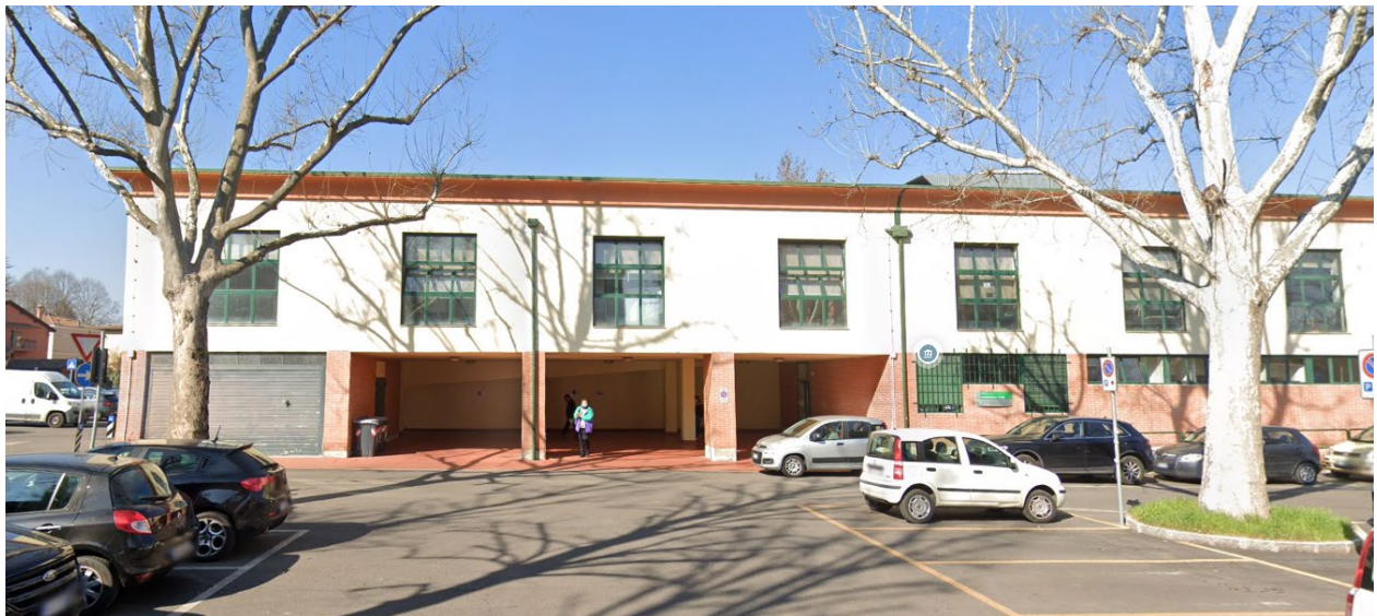
Figura 5 Immagine esterna Via Mameli – Portico oggetto di intervento
