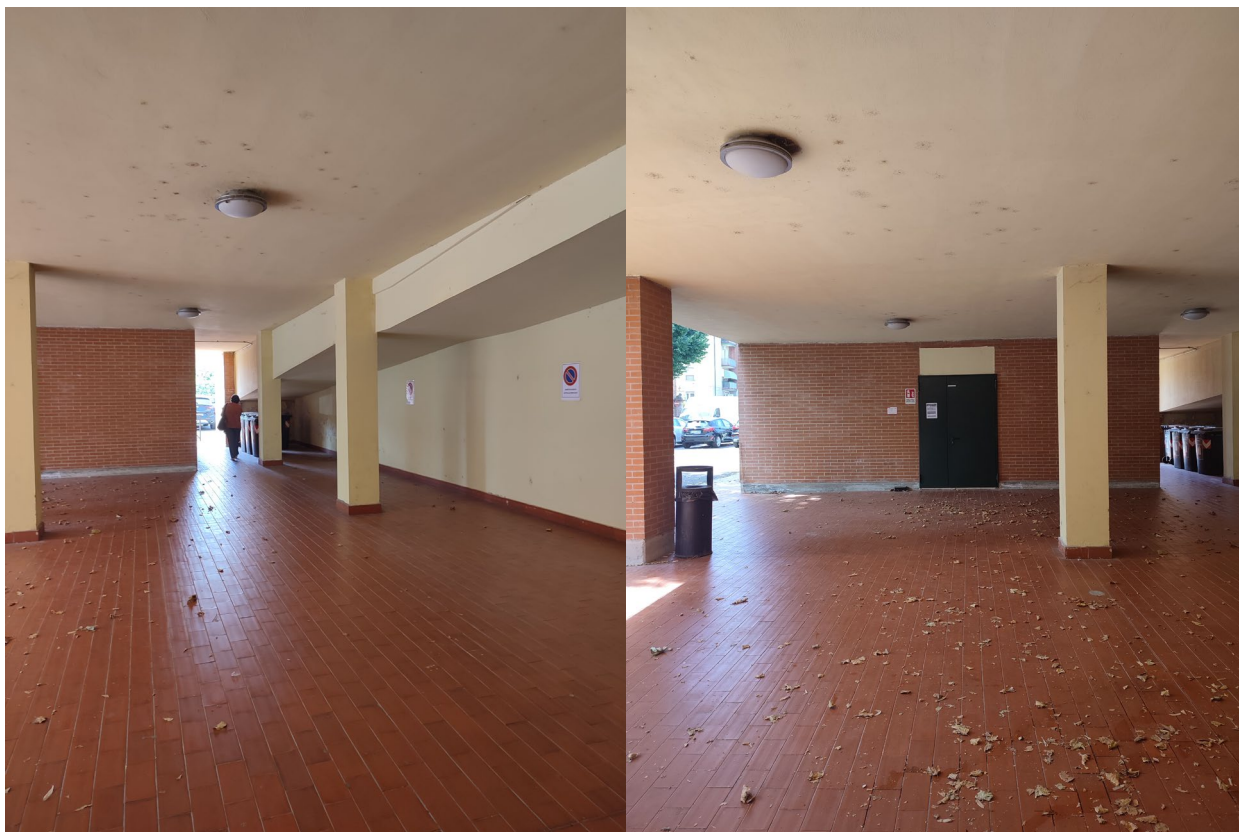
Figura 6-7 - Immagine Portico oggetto di intervento
